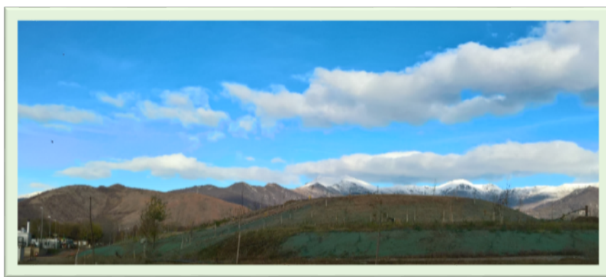
Vista del Lotto 2, attualmente in post gestione
